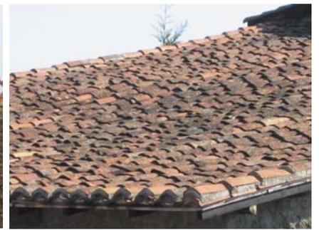
Une technique spécifique nous est parvenue avec les tuiles « canal » : les génoises. Elles se déclinent sous de nombreuses formes, avec des tuiles, des briques (au Nord)...
