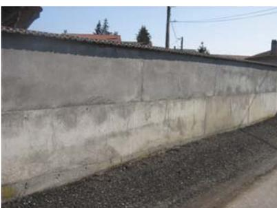
Béton banché avec granulats
