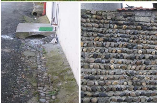
Les moellons de pierres de ramassage : En de nombreux pays, la pierre à bâtir n'était que de la caillasse simplement ramassée et appareillée lorsqu'elle est régulière –ce qui est rare. Les pierres les plus grosses sont disposées en parement sur les deux faces du mur et un bourrage fait de cailloux mêlés de mortier de chaux, remplit l'espace conservé entre les deux parements. Ces murs s'observent dans les pays d'arkose, de cheires... les pépérites.
