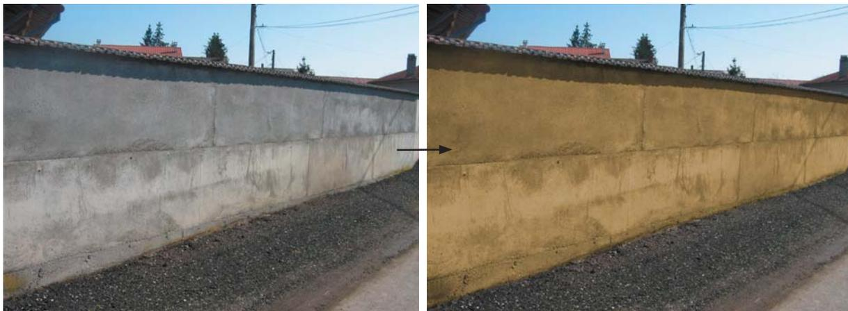
Dans la réalisation on doit porter une attention particulière aux rythmes créés par les écarteurs et les joints de banches (calepinage); on peut également créer des textures en utilisant des fonds de coffrage spéciaux.
