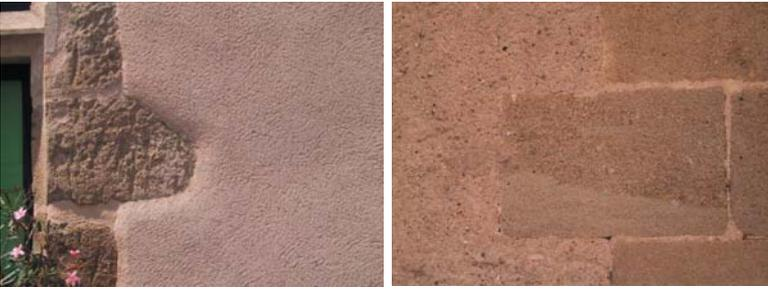
Arrêt du crépi sur la pierre d'angle : à gauche arrêt irrégulier, matériaux épais effet de bosse; à droite le crépi vient se fonder sur la pierre (mais les joints avaient été décapés au préalable)
