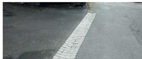
*Le caniveau central ne permet pas toujours de traiter les seuils, l'enrobé revient vers les portes*
