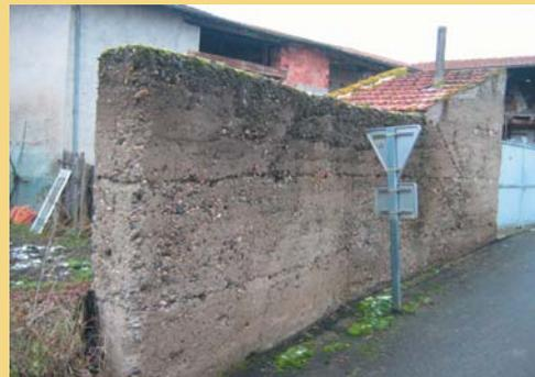
Murs en béton banché fortement marqués par les granulats utilisés (graviers de l'Allier)
