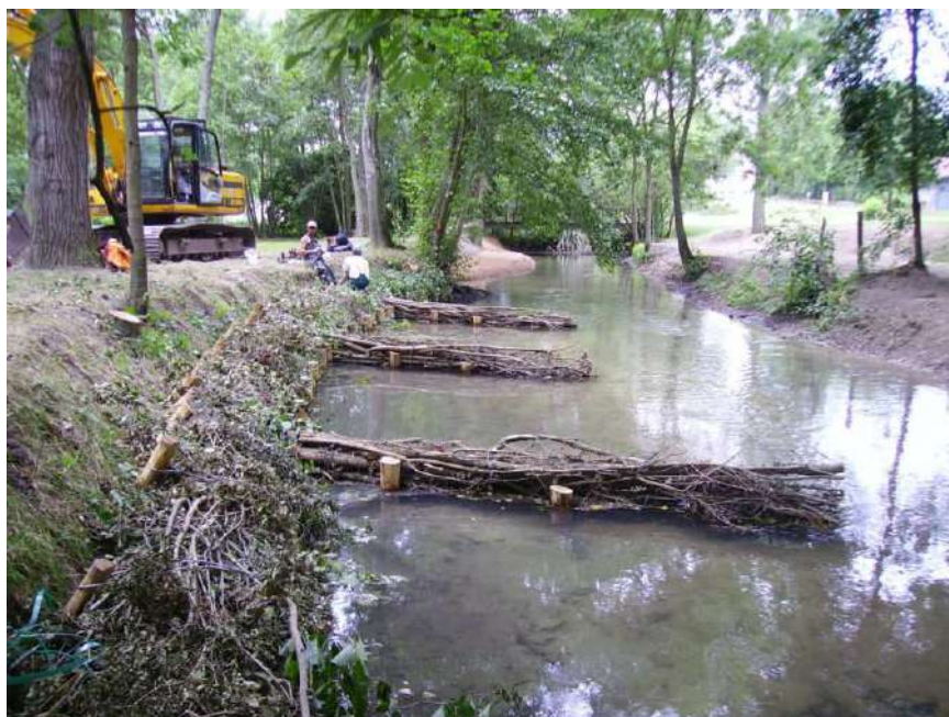
Figure 8: Photo d'épis déflecteurs en bois : bouquets d'arbres. Source : chognot.fr
