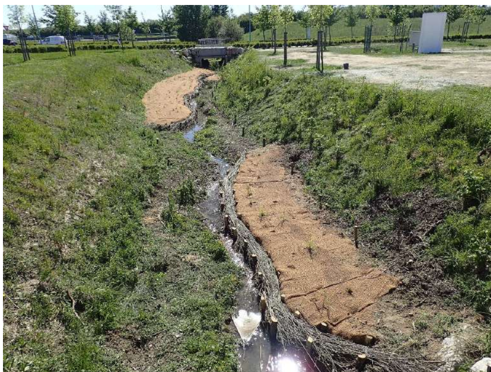
Figure 9 : Photo d'un aménagement de banquettes végétalisées.
