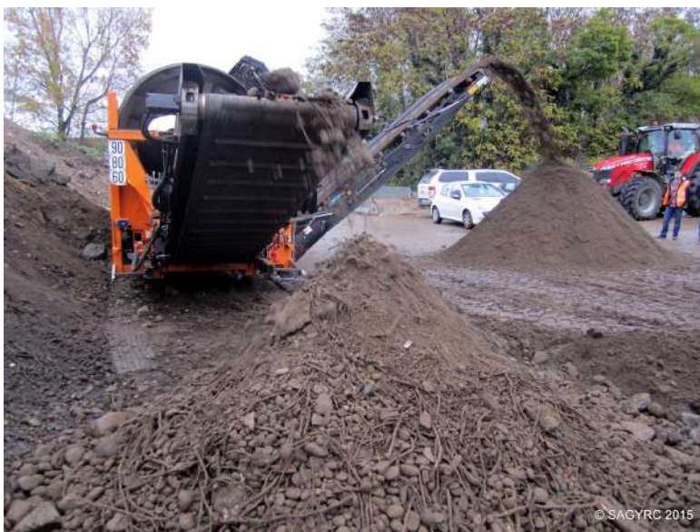
Figure 11: Photo d'un chantier de criblage de sols contaminés à la Renouée du Japon. Source : riviere-yzeron.fr
