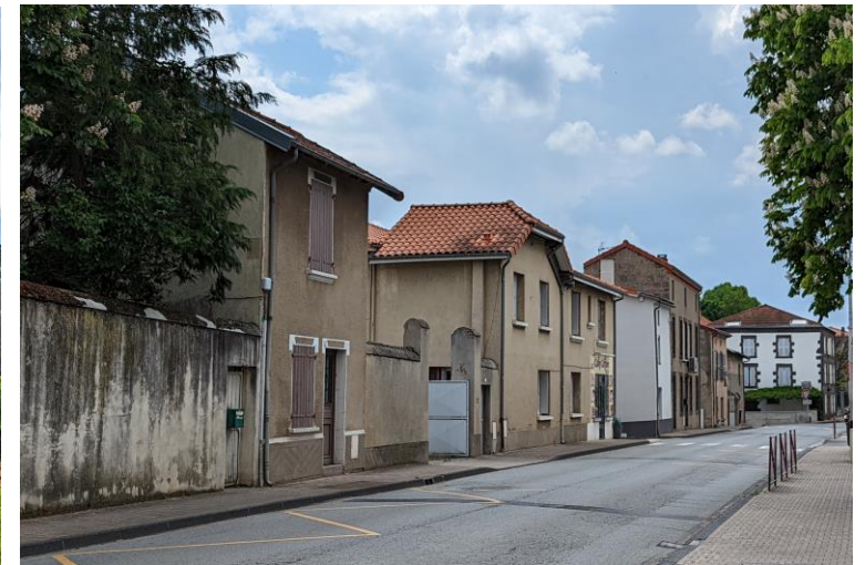
Linéaire bâti à réhabiliter à Joze @Relief urbanisme
