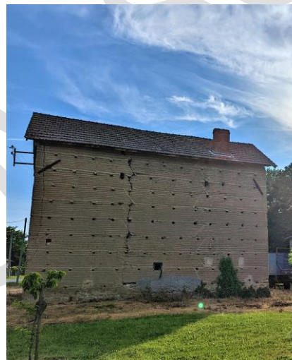
Construction traditionnelle en pisé à Vinzelles
