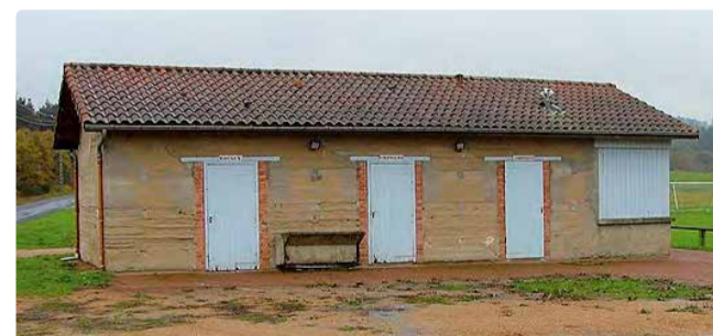
Restauration d'une maison en pisé
