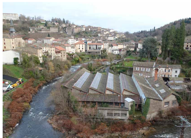
Panneaux parfaitement intégrés aux toitures en shed, soulignant leur rythmique, Olliegues.
