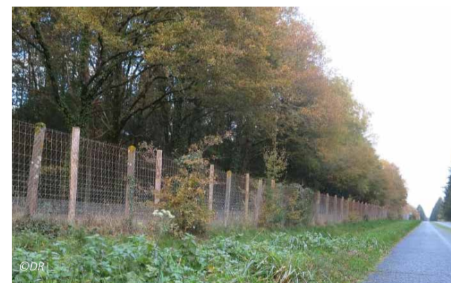
Double clôture en piquet châtaignier et grillage (deux rangs) - hauteur 2m.
