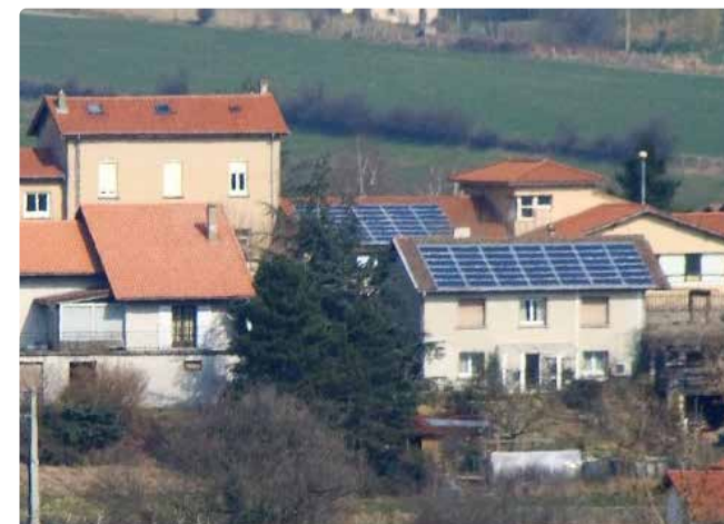
Toitures solaires individuelles, couvrant le maximum de toiture et similaires sur deux pans de toitures. Les Haies, Rhône.
