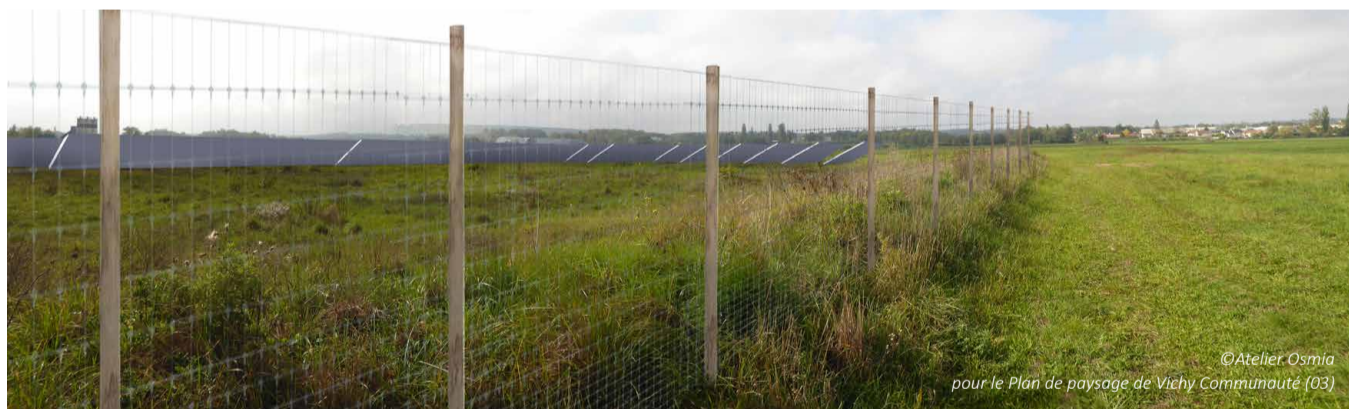
Ci-dessus, simulation d'une clôture en piquets en châtaignier et grillage à maille progressive (ursus lourd), dont le bois s'harmonise dans le contexte agricole et naturel. A l'arrière d'un projet de parc photovoltaïque simulé sur une friche. Hauteur 2m
