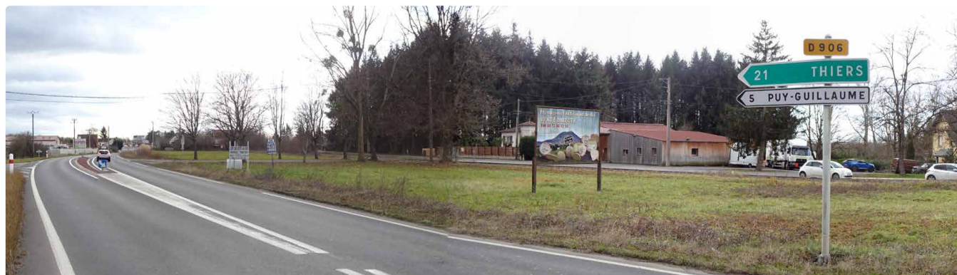
Coupure d'urbanisation le long de la D906 en entrée de bourg de Ris
